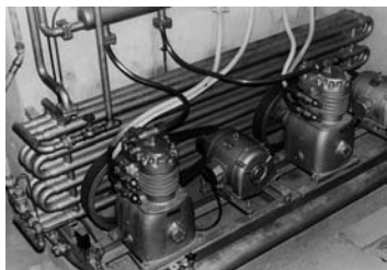
Kühlanlagenbau in den 1950er Jahren.
